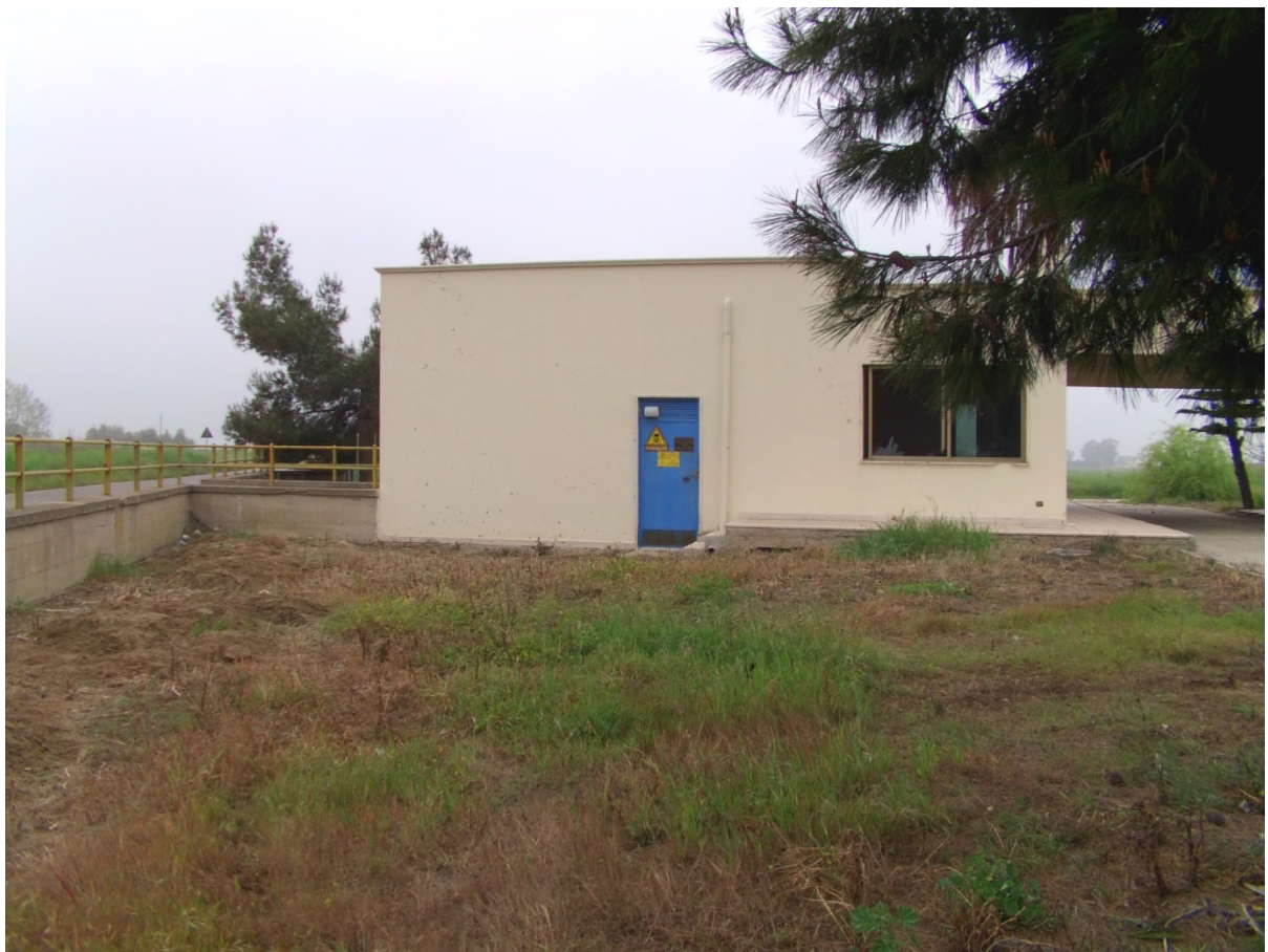
Foto 1 CABINA ARRIVO LINEA
