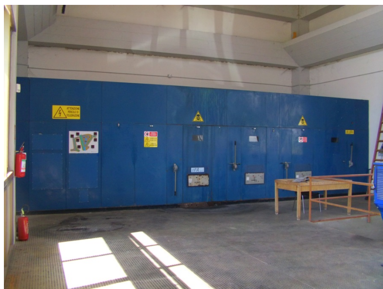
Foto 5 – scomparto MT 20kV esistente in sala idrovore
