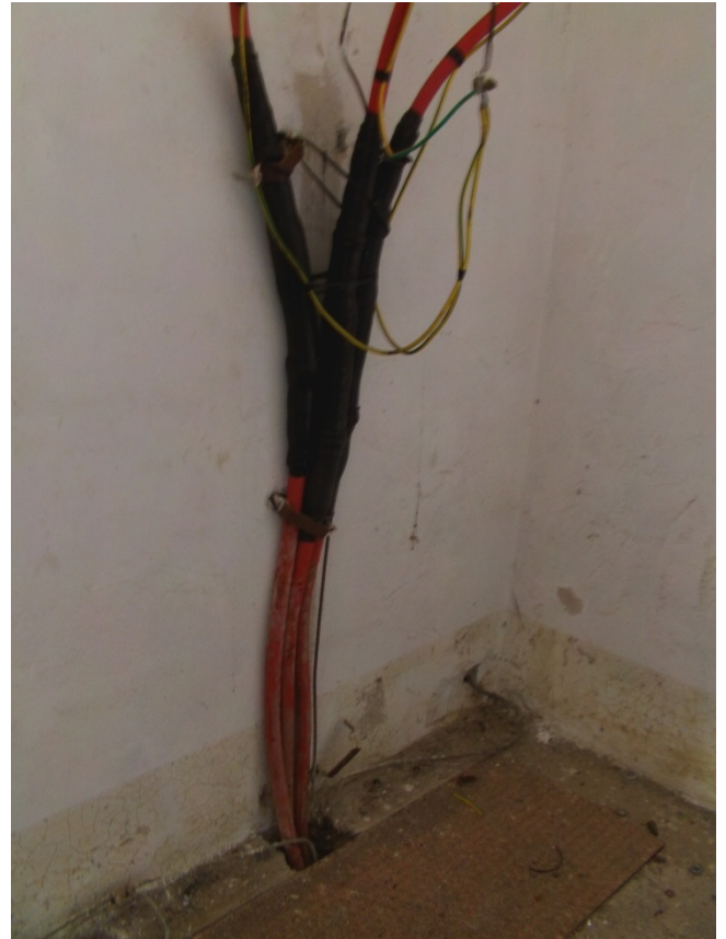
Foto 3 – muffola esistente su cavo MT in CAL
