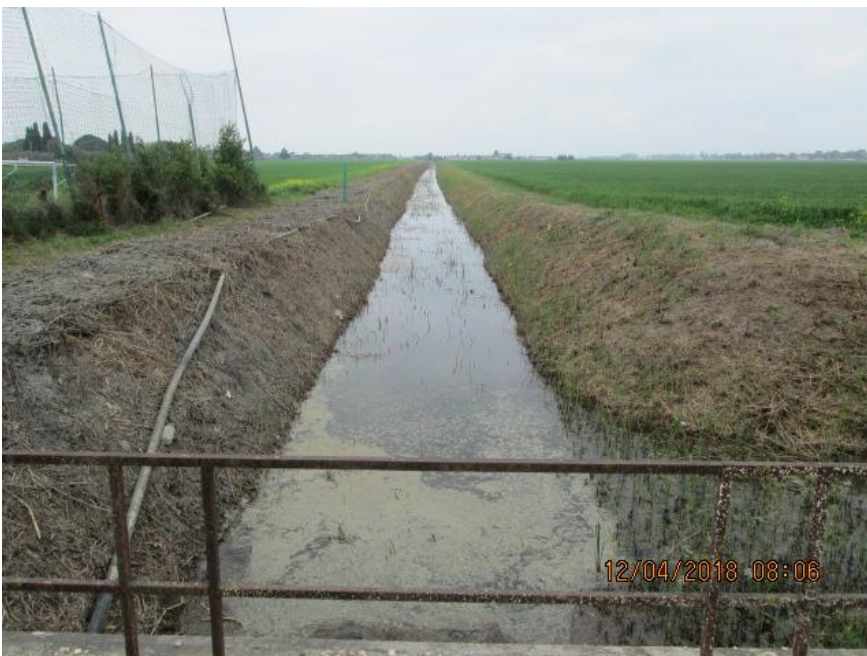
Foto 2 – Attraversamento Riva dei Tessali, post-intervento
