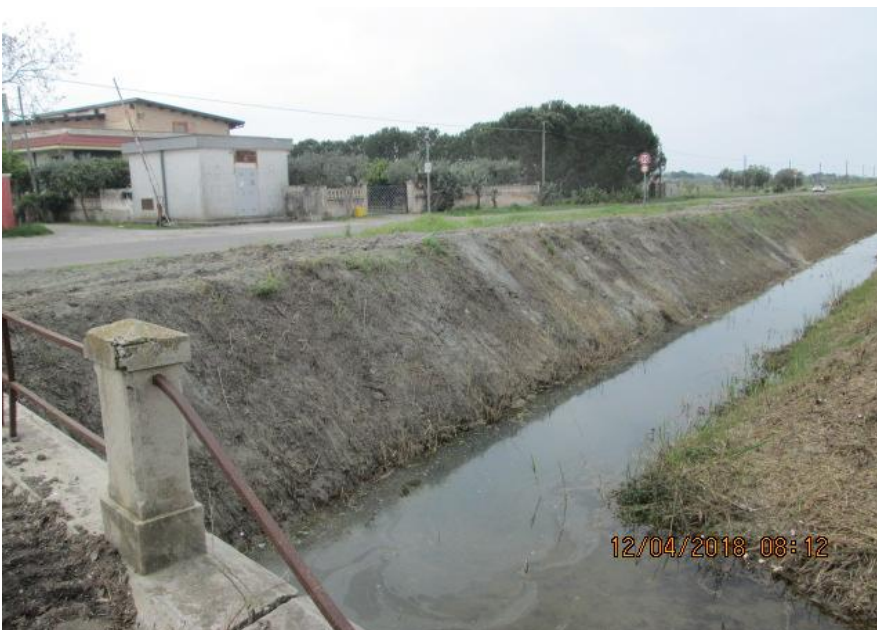
Foto n.4 – Canale Mezzana- strada comunale, post-intervento
