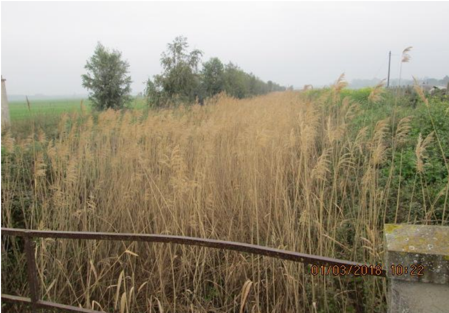
Foto 1 – Attraversamento Riva dei Tessali, pre-intervento
