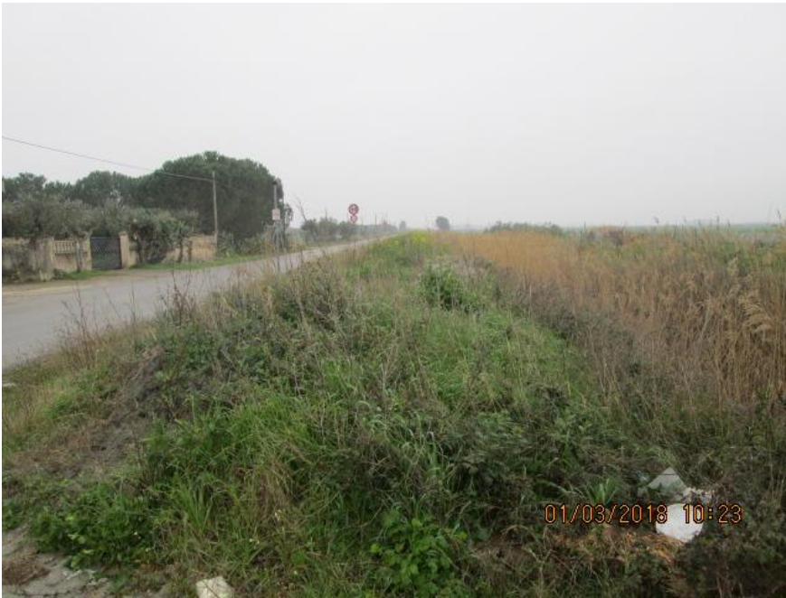
Foto n.3 – Canale Mezzana- strada comunale, pre-intervento
